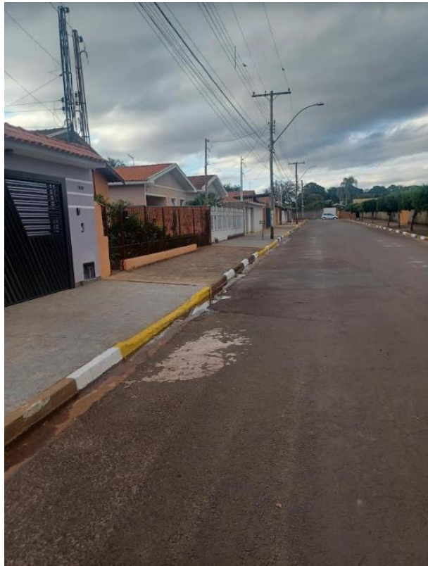
Figura 65. Detalhes da pintura das sarjetas na Rua Fernando Bertazzo (549,60 metros de guais e sarjetas no total dos dois lados)
