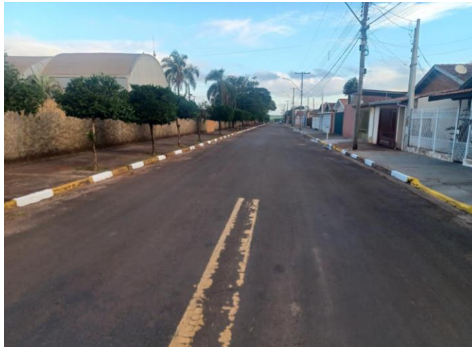
Figura 61. Detalhes das Guias e Sarjetas na Rua Fernando Bertazzo (549,60 metros de guias e sarjetas) – Proximidade com o Centro Rural de Tanquinho
