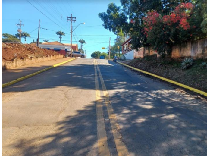
Figura 70. Detalhes da pintura das sarjetas na Entrada do Bairro de Tanquinho (Dimas C. Ometto)
