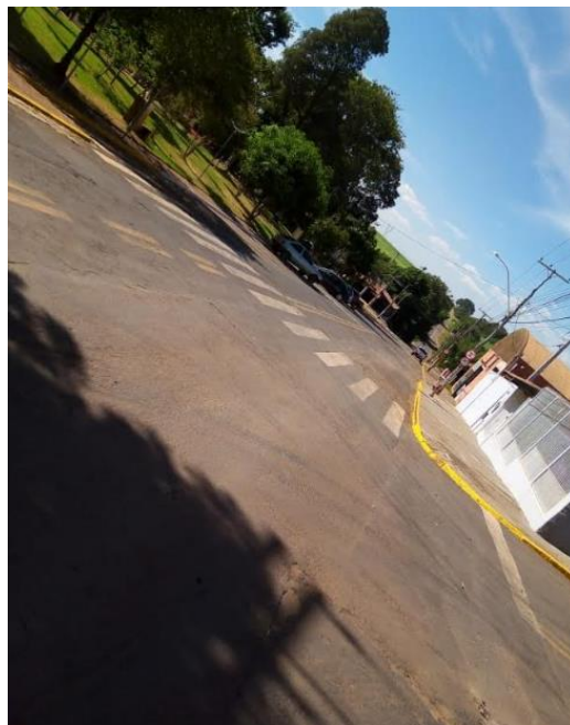
Figura 53. Detalhe da limpeza e pintura das Sarjetas na Rua Dimas Cerra Ometto (781,88 metros de guias e sarjetas – total dos dois lados): foto 13/05/2024 proximidade da praça Imaculada Conceição.
