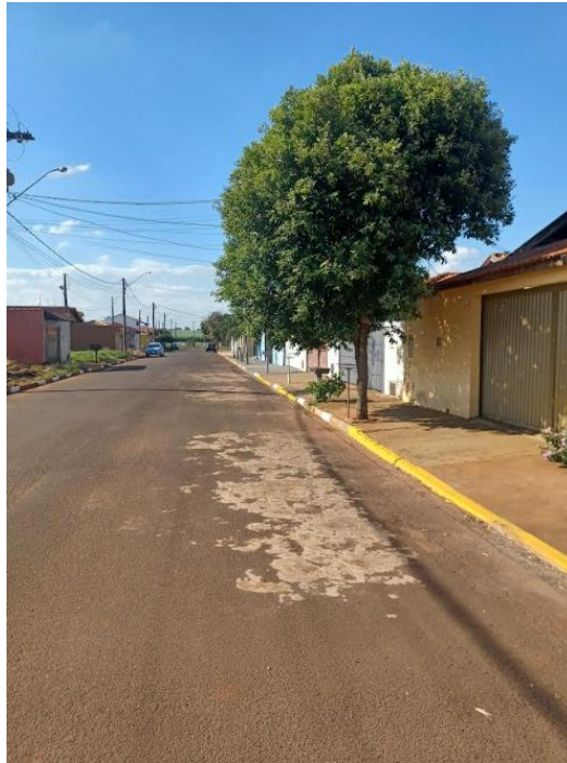
Figura 56. Detalhes da limpeza e pintura (amarelo e branco) da rua Angelina Nozella Faganello com 382,34 metros de guias e sarjetas total dos dois lados (13/05/2024)
