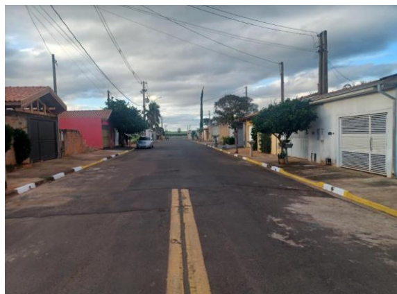
Figura 67. Detalhes da pintura das sarjetas da Rua Angelina Nozella Faganello (535,54 metros de guias e Sarjetas total dos dois lados – foto 29/05/2024)
