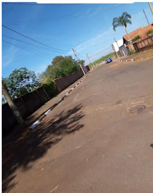
Figura 54. Detalhes da pintura das Sarjetas na Rua Fernando Bertazzo (549,60 metros de guias e sarjetas – soma dos dois lados): foto 13/05/2024
