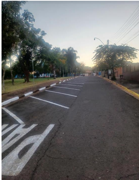
Figura 73. Detalhes da pintura de Sarjetas na Travessa Aziz Neme
