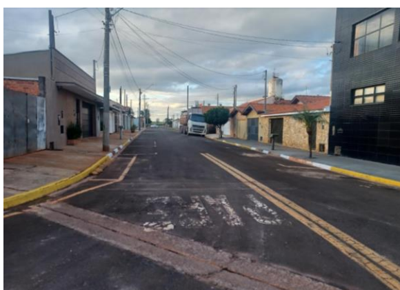
Figura 69. Detalhes da pintura das Sarjetas na Rua Vicente Vicente Lopes da Silva (491,54 metros de guias e sarjetas – total dos dois lados)
