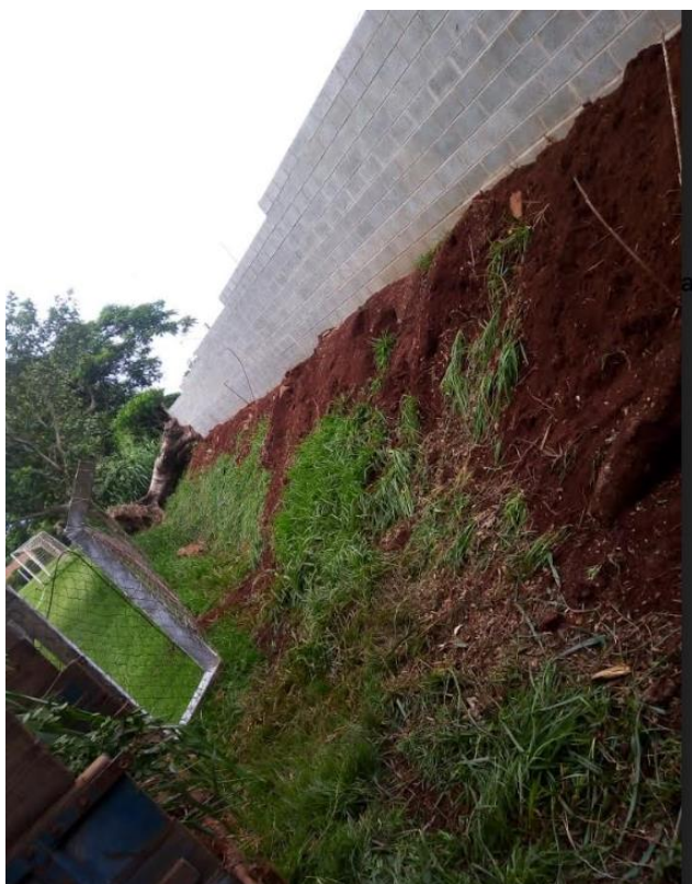
Figura 92. Serviços da Zeladoria Comunitária na limpeza da área de queda de árvores de grande porte e reconstrução do muro (120 metros quadrados)
