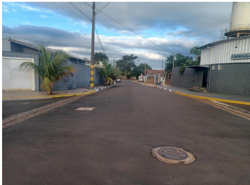
Figura 66. Detalhes da pintura das sarjetas na Rua Benedito A. Junior (372,13 metros de guais e sarjetas no total dos dois lados)
