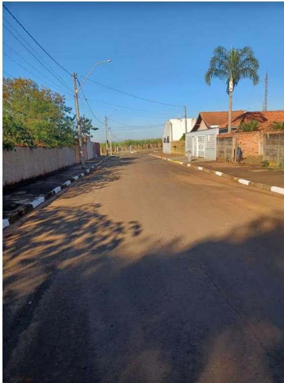
Figura 74. Detalhes da Pintura de Sarjetas na rua Vitório Fornazier (foto: 31/05/2024)
