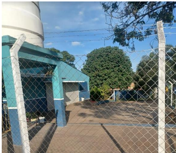
Figura 40. Detalhes atuais da Escola Municipal Ada Buzelli Neme em Tanquinho. Area adquirida com recursos do CRT e desapropriação amigável da Prefeitura Municipal de Piracicaba
