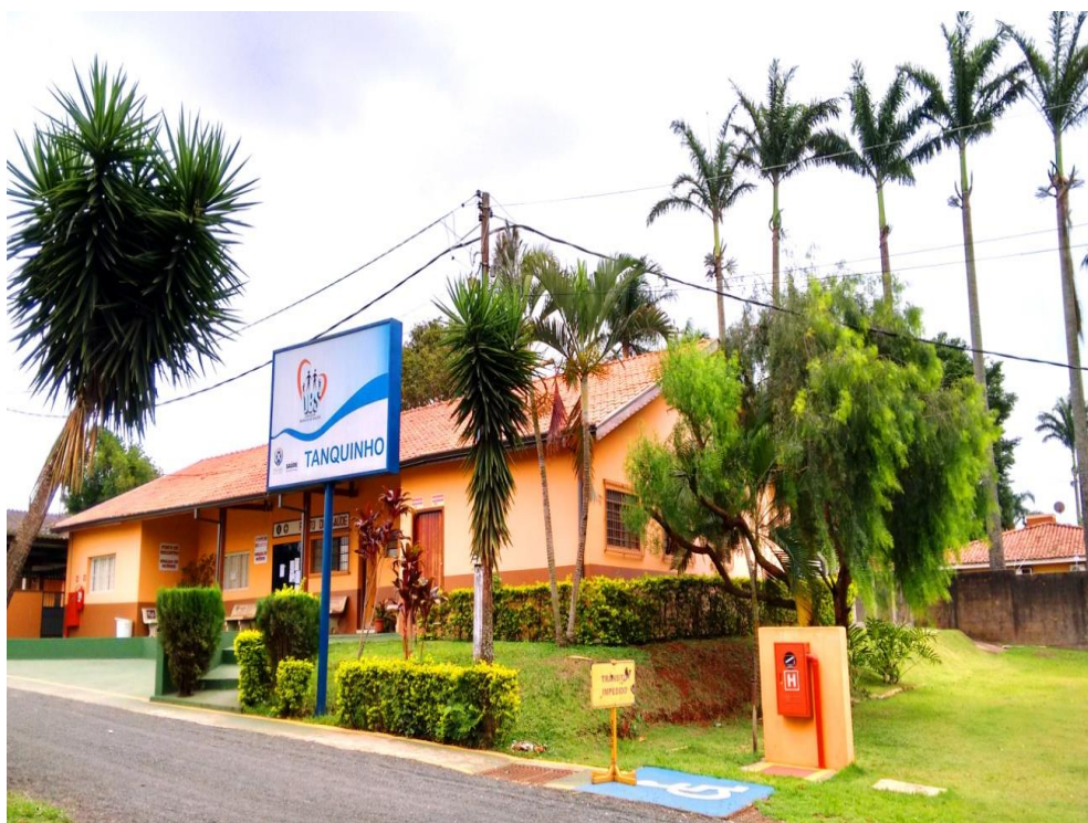
Figura 30. Detalhes da Unidade Básica de Saúde de Tanquinho nas dependências do Centro Rural de Tanquinho (área construída da ordem de 340 metros quadrados) – Verde e ótima infraestrutura para atender a comunidade na área de saúde
