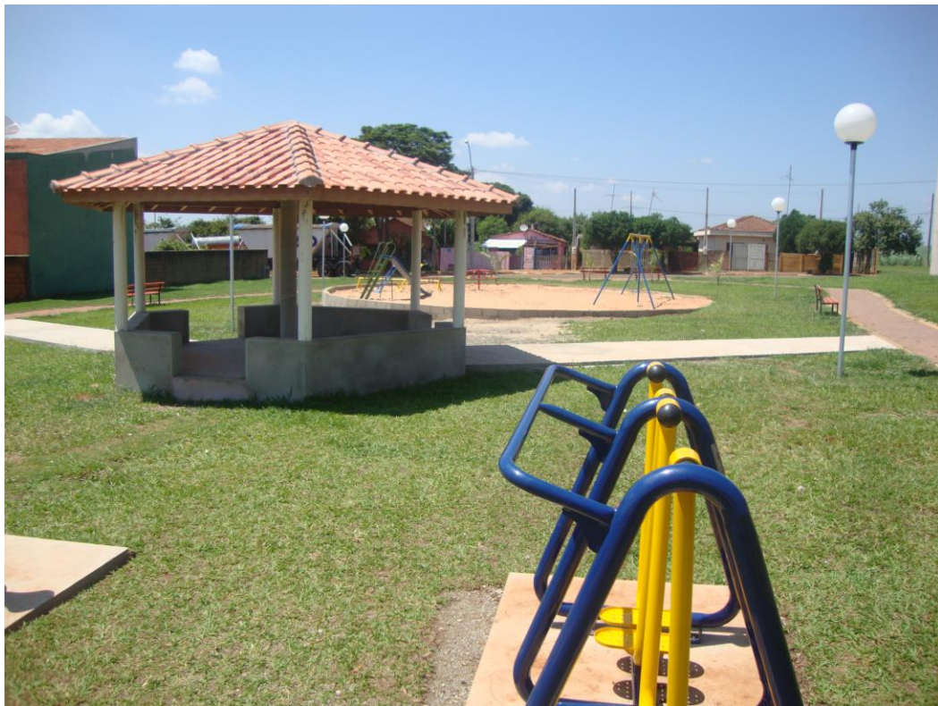
Figura 15. Detalhes da nova praça Pedro Leite do Loteamento Recanto Feliz, após revitalização da área em 2014 (academia ao ar livre, quiosque, gramado, iluminação, parque infantil, entre outros).
