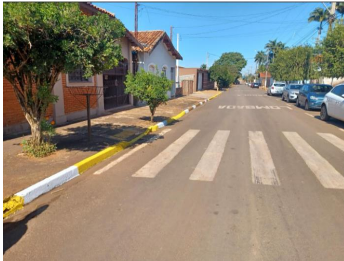
Figura 58. Detalhes da pintura de sarjetas na Rua Alberto Cury (1.623,10 metros de guias e sarjetas – foto 29/05/2024) – Proximidade com a Escola Estadual Prof. João Alves de Almeida.
