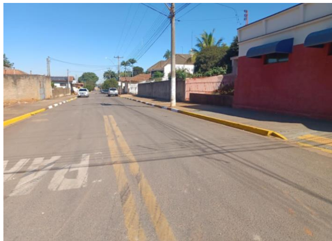
Figura 59. Detalhes da Rua Alberto Cury em Tanquinho (foto: 29/05/2024)
